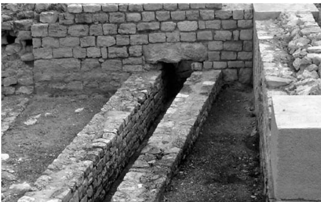
Una parte del sistema de alcantarillado y calefacción ( hipocáustos ) en la ciudad romana de Segóbriga, Cuenca, precursor de las glorias castellanas.
